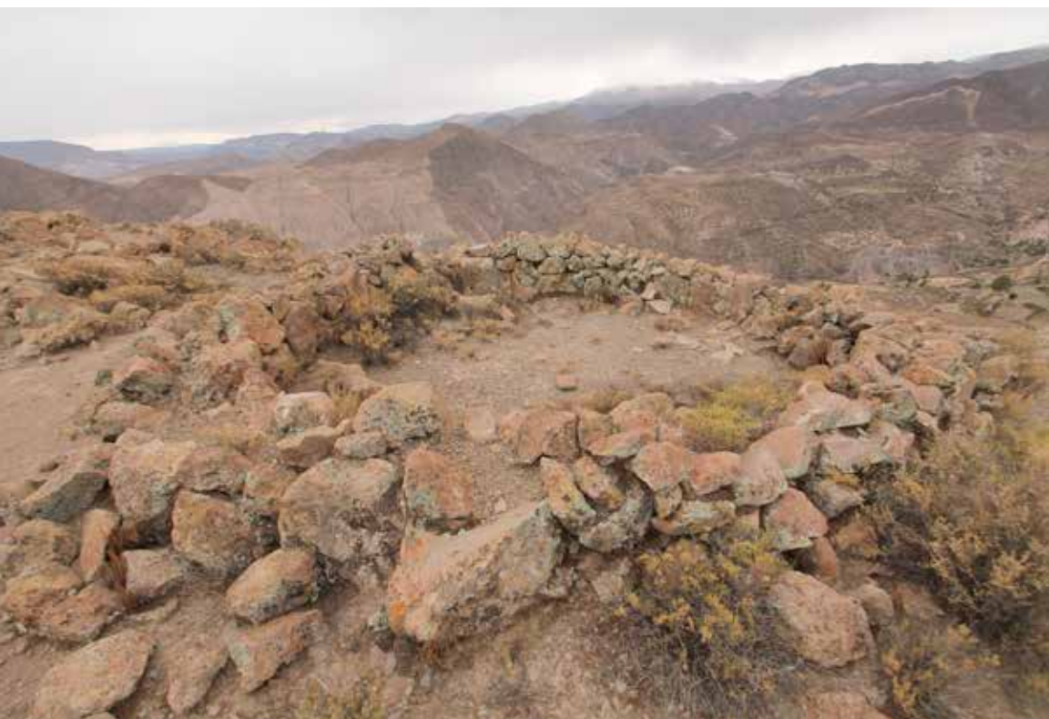
Imagen 60 Asentamiento Calacruz. En el muro perimetral de la construcción, se observa el sistema constructivo de doble pared de piedra, rellena con tierra. Al fondo se observan los cultivos de Aroma.
