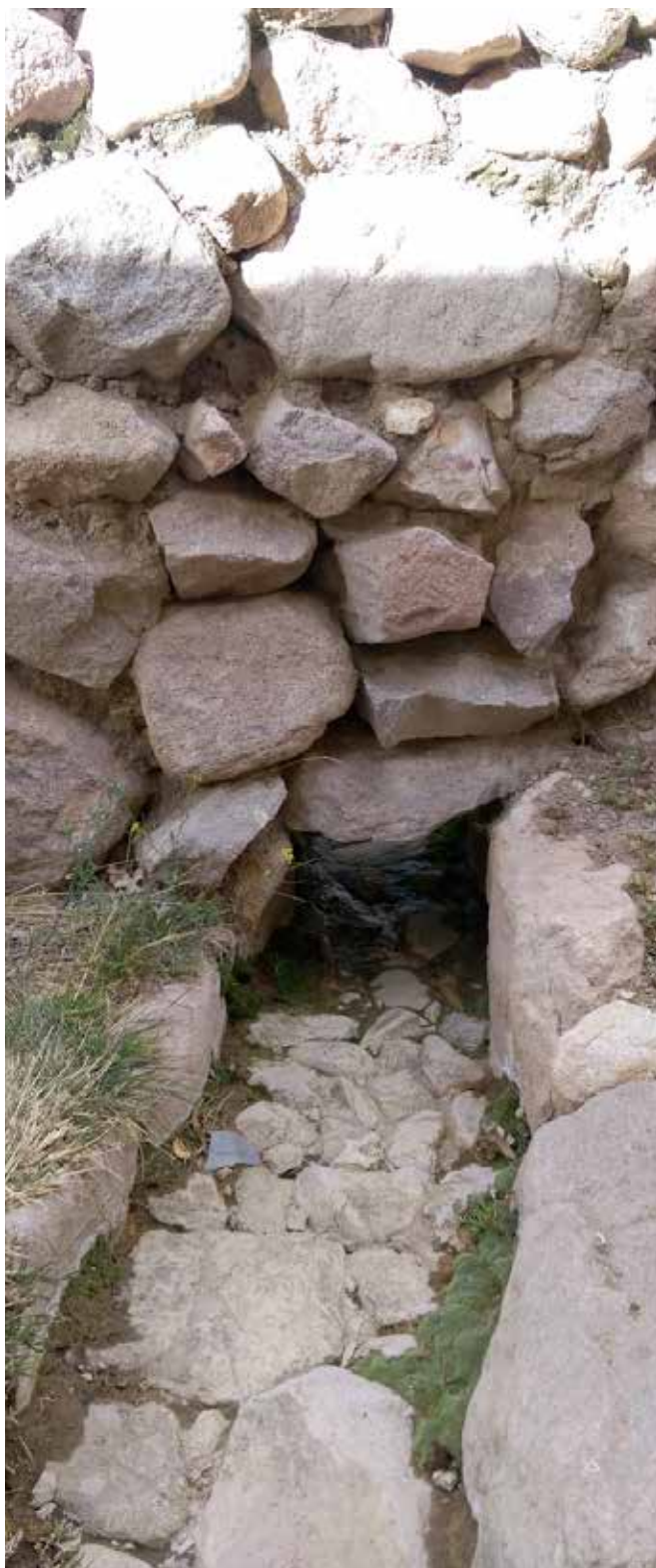
Imagen 54 Canal de riego derivado del canal Pueblo, cruzando una pirca divisoria de un terreno. (RCHJ, 2016)
