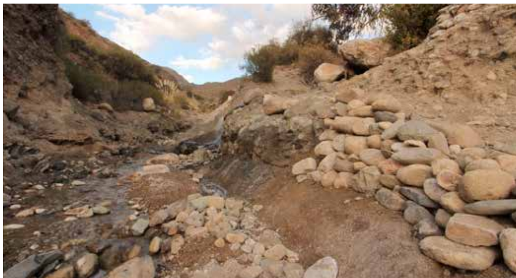
Imagen 56 Rio Socoroma, en cruce de Camino Real
